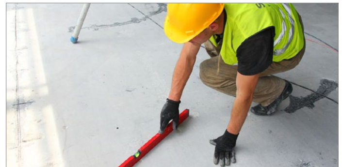
ZDJĘCIE 1. POMIAR PŁASZCZYZNY – DOPUSZCZALNY MARGINES BŁĘDU WYNOŚI +/- 3 MM, NA DŁUGOŚCI 2 M.
