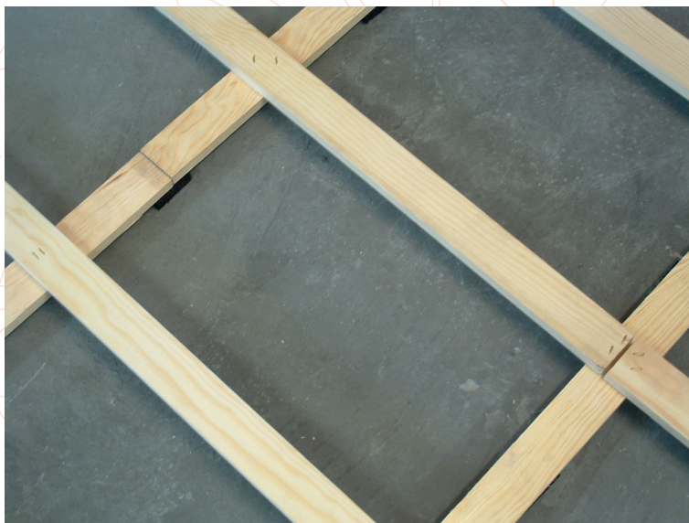
Fot.1. Połączenie listew dolnych z listwami górnymi.
